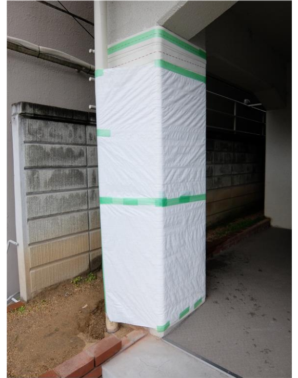
경화 단계 및 이후 건축 마감재 시공
