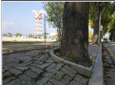
가로수 뿌리 경계석 보도면 돌출 전도 안전 사고 상존(사례6)
