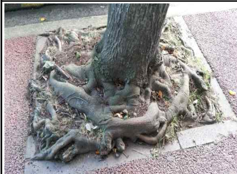
가로수 뿌리 경계석 보도면 돌출 전도 안전 사고 상존(사례5)
